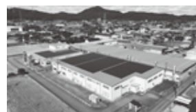
自家消費型太陽光発電設備
